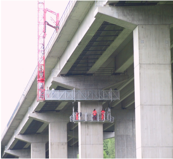
Abb. 5: Bauwerksprüfung A93, Große Waldnaabbrücke
