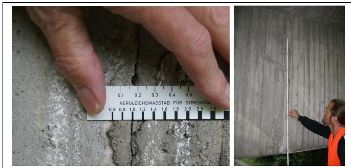
**Bild 8** Ausgeprägter Koppelfugenriss; *Quelle: KHP*
