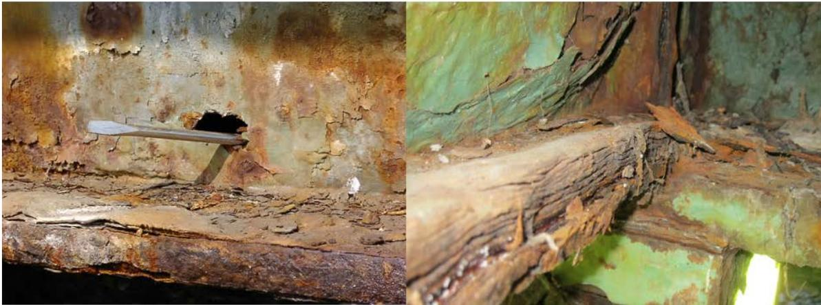
**Bilder 1 / 2** Lochfraßkorrosion / Querschnittsschwächungen
