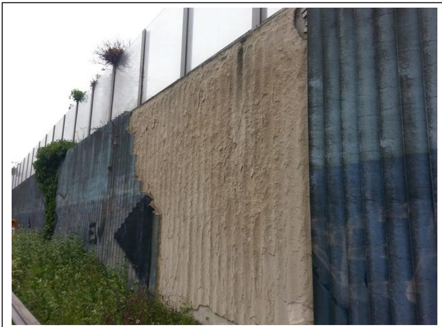
**Bild 1** Geschädigte LSW mit Vorsatzschale aus Einkornbeton
