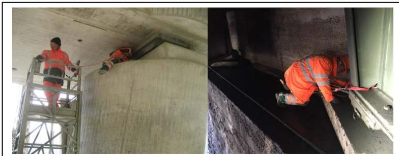
**Bild 3** Lagerprüfung mit Absturzgefährdung (Straßen.NRW)
