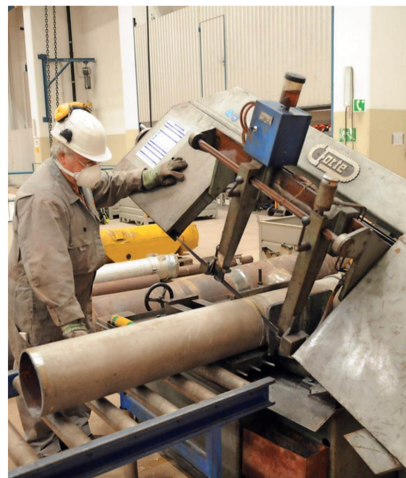
Demontagarbeiten im Maschinenhaus des stillgelegten Kernkraftwerks in Obrigheim im Jahr 2009; das von der EnBW betriebene Kraftwerk wurde 2005 abgeschaltet. FOTO: DPA
