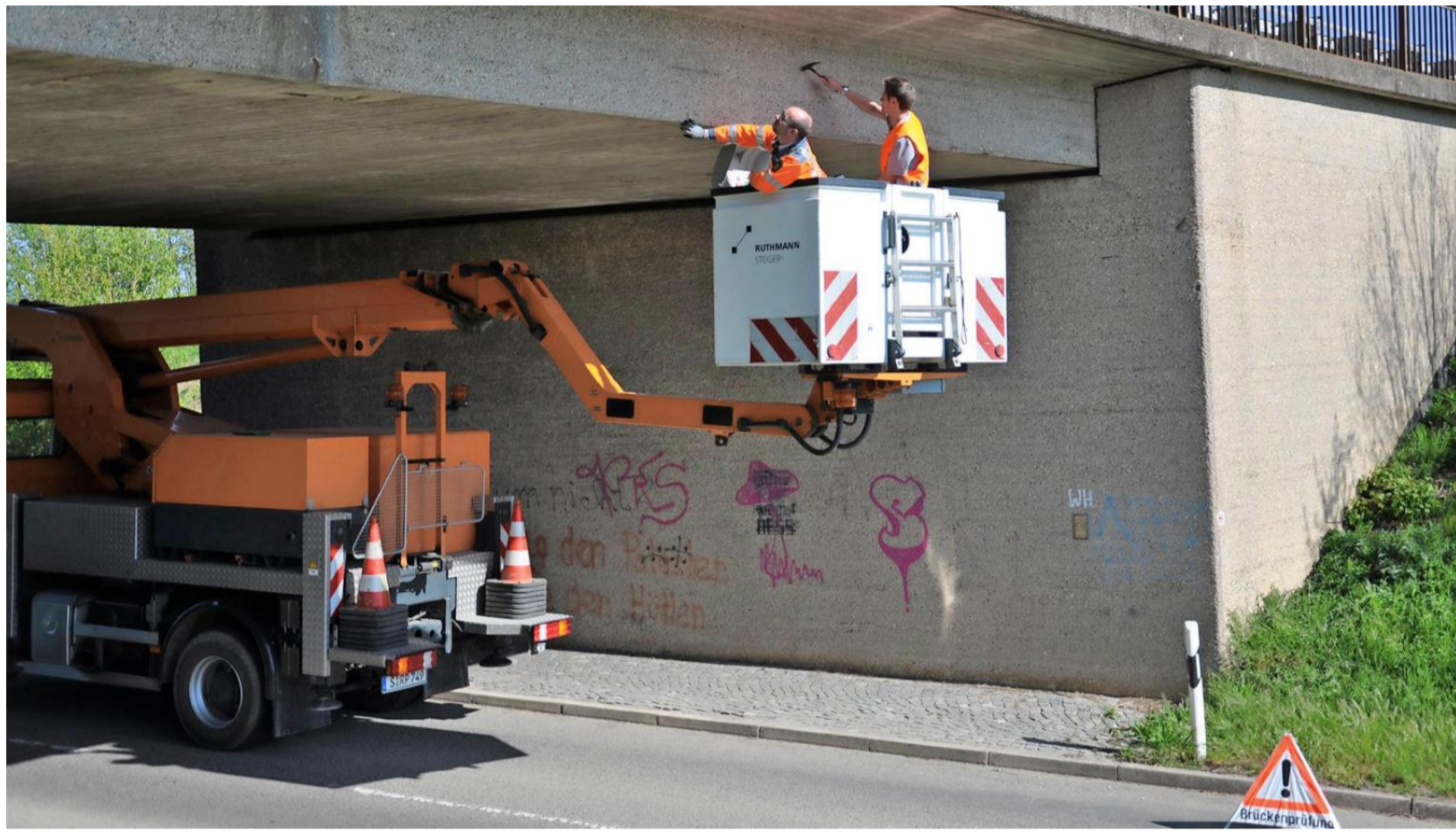
Jeder Zentimeter wird begutachtet: Bauingenieur Michael Lutz (im Hubsteiger links) ist einer der drei Brückenprüfer im Regierungspräsidium Stuttgart. FOTO: BÄUERLEIN
