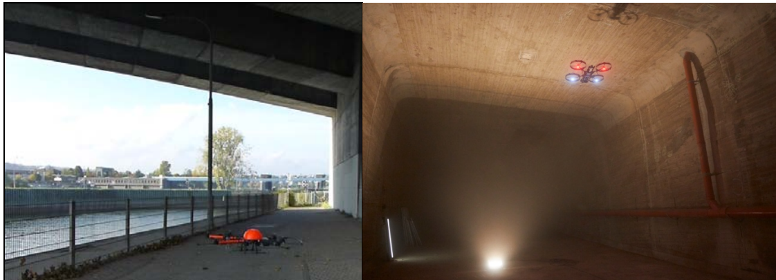
Abb. 4: Befliegung Europabrücke Koblenz (TÜV)
