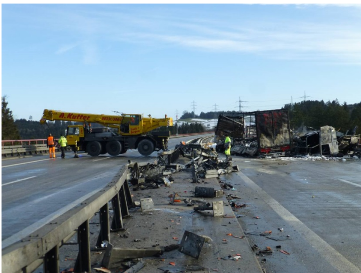
Abb. 10: Der Tag danach, Bergungsarbeiten
