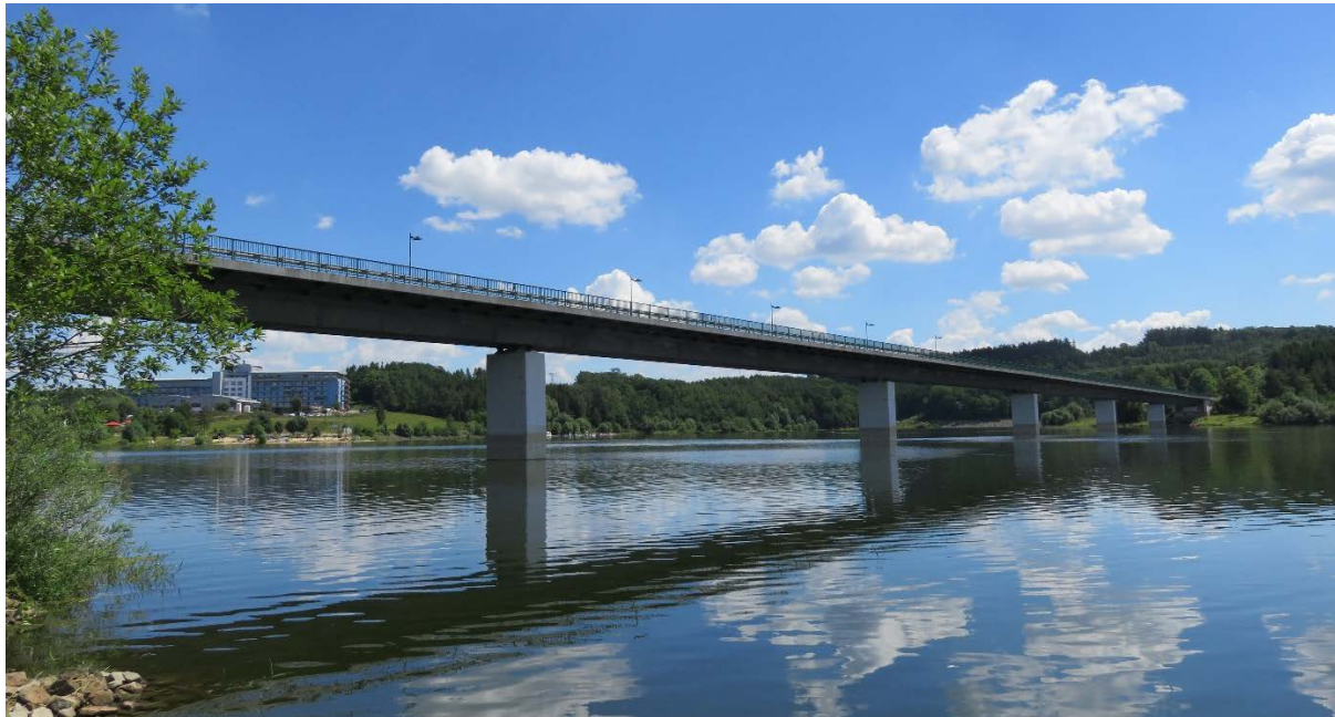
Abb. 1: Ansicht der Stauseebrücke Zeulenroda (2016)
