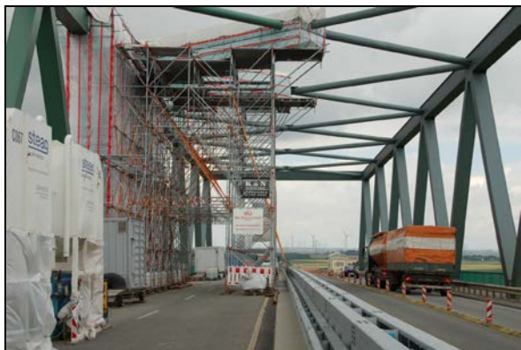
Abb. 12: Instandsetzungsarbeiten an der Hochbrücke Brunsbüttel
