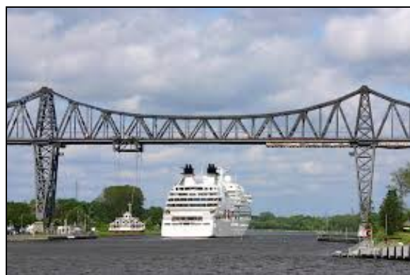
Abb. 11: Eisenbahnhochbrücke Rendsburg mit Schwebefähre
