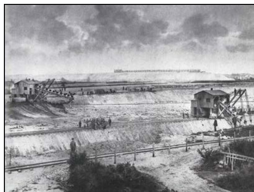
Abb. 2: Kanalbauarbeiten bei Grünenthal
