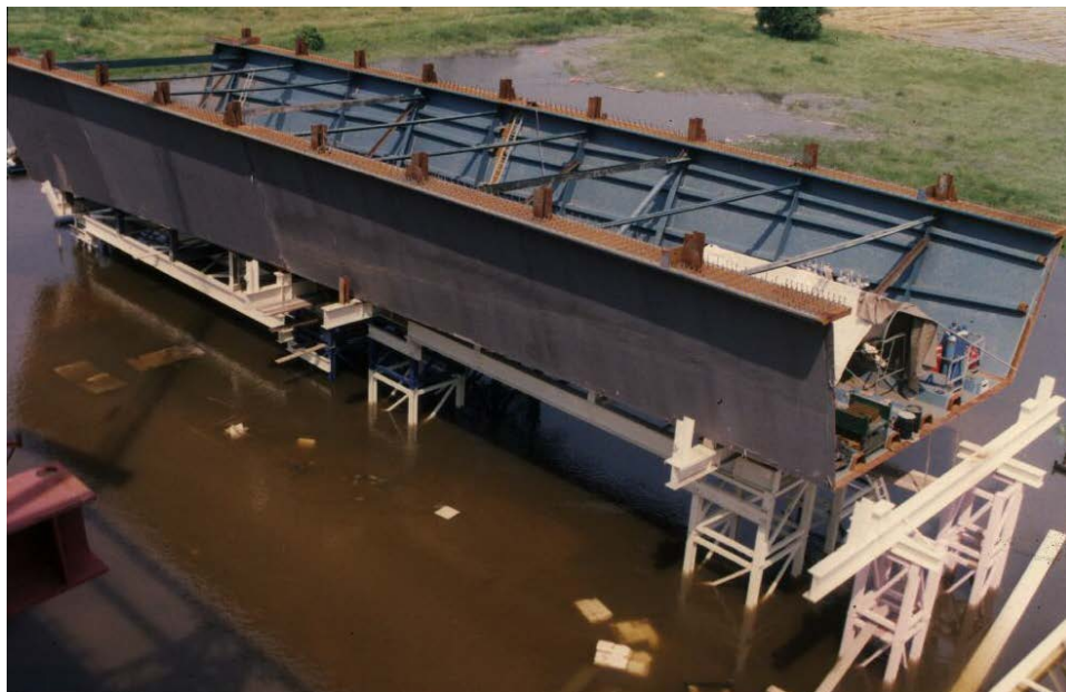
Abb. 7: Hohlkasten vor Betonage der Fahrbahnplatte (Quelle: Bauwerksakte)
