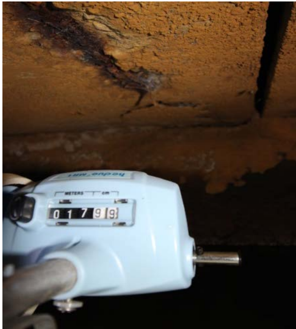
Abb. 21: Ausschnitt aus Aufnahme der Messeinrichtung am Bauwerk
