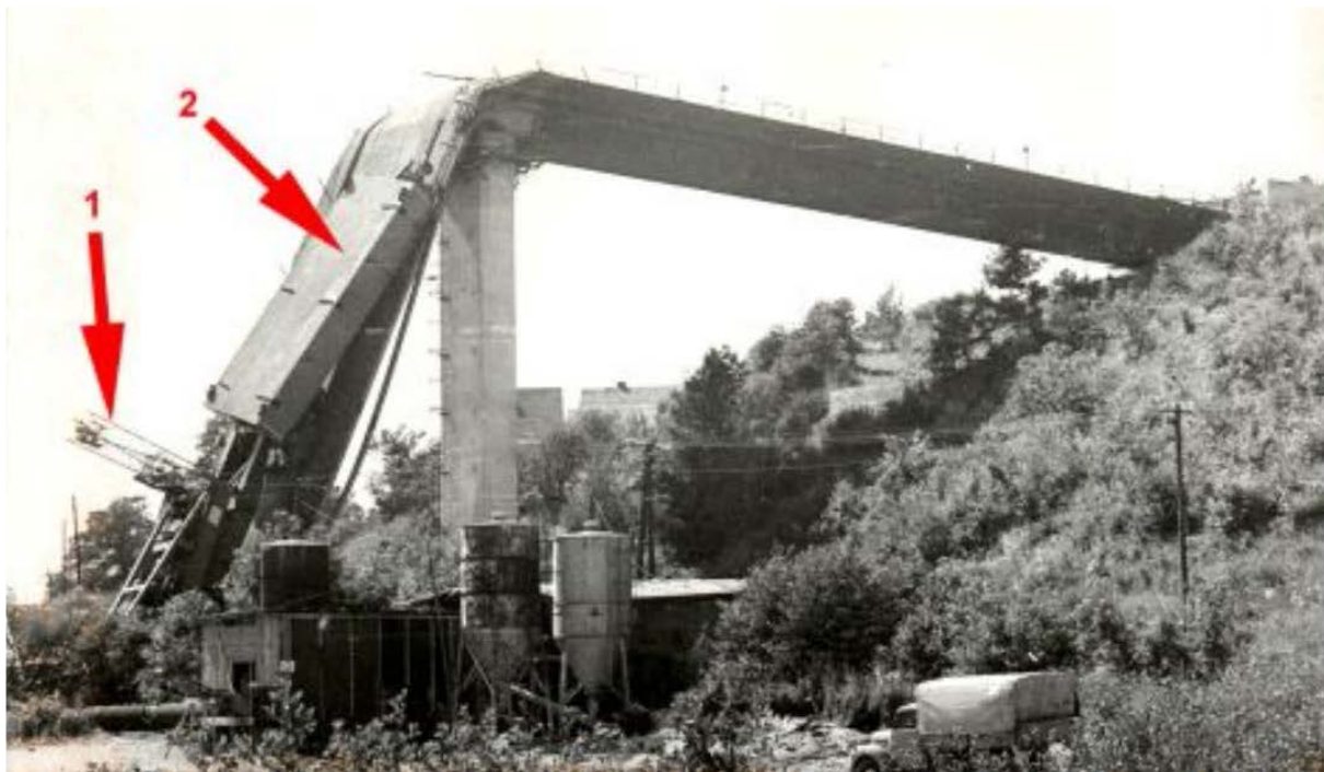
Abb. 5: Ansicht nach dem Einsturz (Pfeil 1 – Vorbaukran, Pfeil 2 – Segment 8 des Überbaues)
