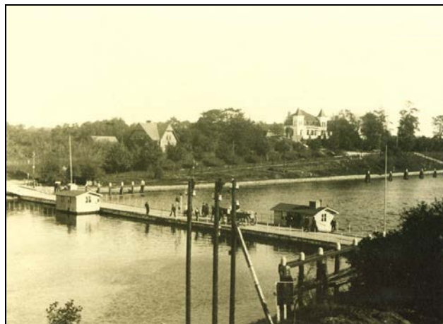
Abb. 4: Prahmdrehbrücke in Kiel-Holtenau
