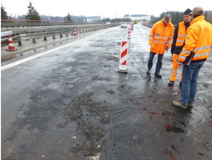
Abb. 11: Belagsschäden
