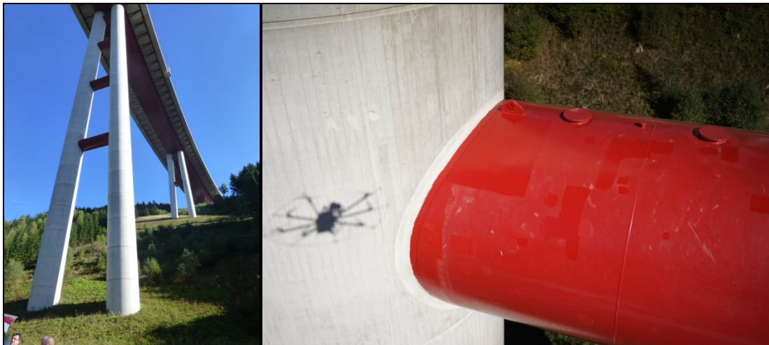
Abb. 3 Talbrücke Nuttlar (Pfeiler und Versteifungselement) (TÜV)
