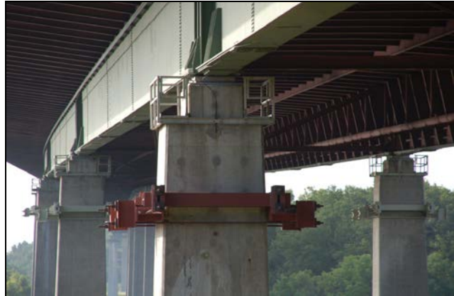
Abb. 15: Pfeilerkopfverstärkung Rader Hochbrücke
