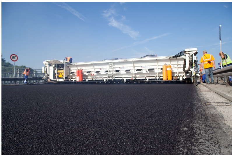
Abb. 6: Fahrbahninstandsetzung im Jahr 2013 (Quelle: Eurovia Magdeburg)
