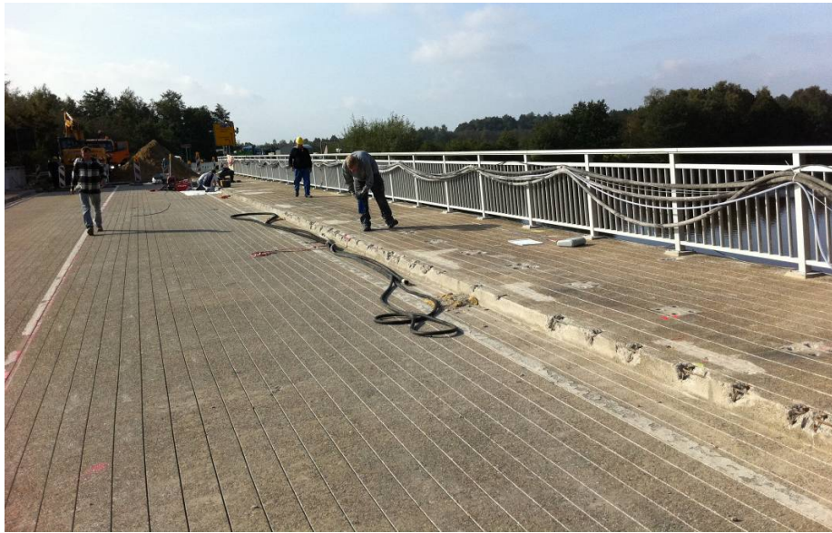
Bild 2: Schlitze zum Einbringen der MMO-Titananodenbänder
