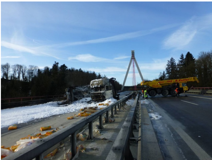
Abb. 9: Der Tag danach, Bergungsarbeiten
